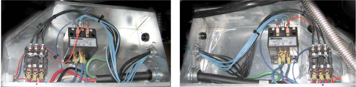
Ansicht von links und rechts der mechanischen Schaltschützkomponenten
